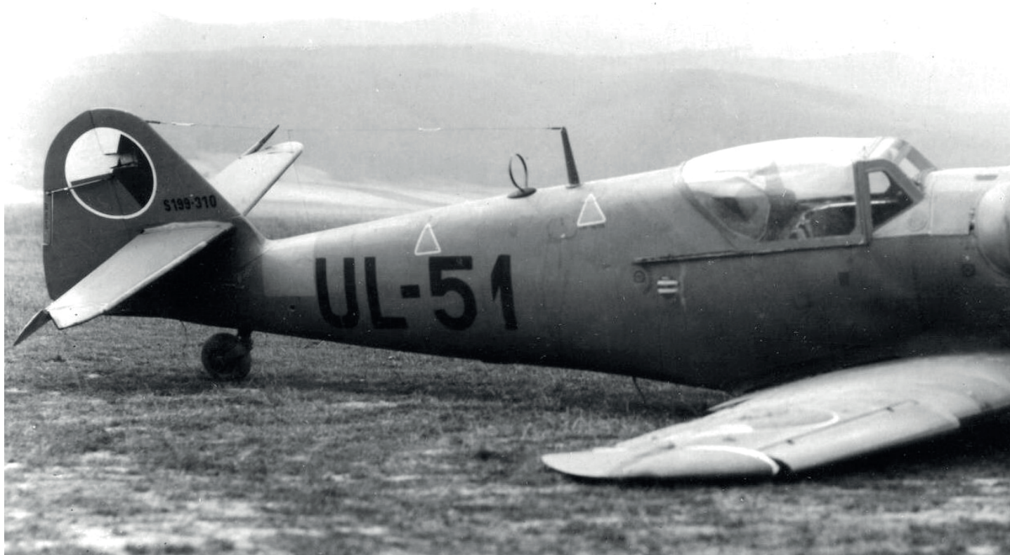
Snímek bývalé průzkumné „Aerovky“ S-199.310, UL-51, od 5. leteckého školního pluku, se kterou po kolapsu podvozku již neodstartoval z letiště Zvolen dne 26. 8. 1952 svob. Josef Mucha. Na zadní horní části trupu a shora na křídle je letoun opatřen žlutými identifikačními pruhy. Černé znaky na trupu byly nastříkány přes šablonu a tenké dělicí můstky v linkách písmen a číslic byly zatřeny.
