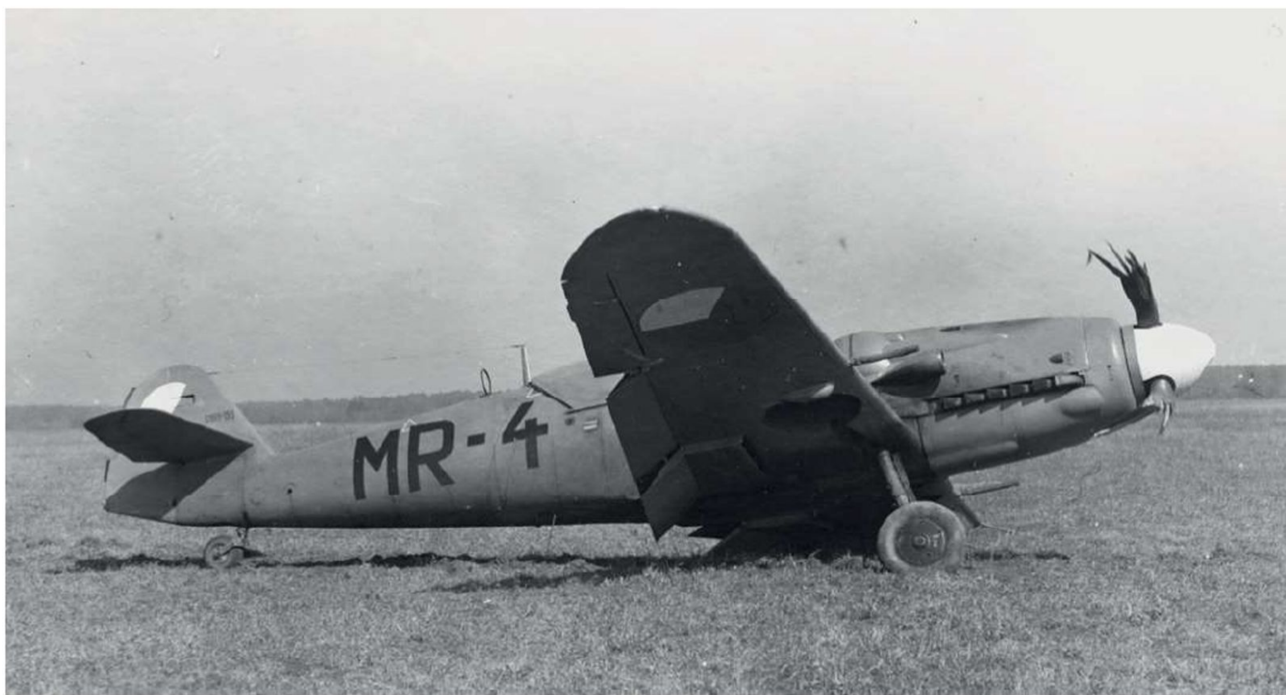
Světle šedozelelou kamuflážní barvou opatřená Avia S-199.155, „černá“ MR-4, od 2. letky LP 8 v Brně-Černovicích. K této havárii došlo 24. 3. 1949, pilotem byl por. František Krist. Záběr na spodní polovinu křídla pěkně ukazuje umístění výsostného znaku s tenkým modrým lemem, dále také „bouličku“ lapače nábojových článků křídelního kulometu vz.17/7,9N a pravý chladič kapaliny s vykllopenou výstupní klapkou; hlavně kulometů jsou opět zakryty plátěnými návleky.
